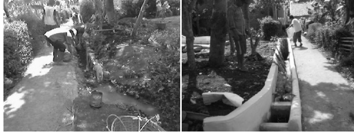
Gambar 4 Proses Pembangunan WWG
